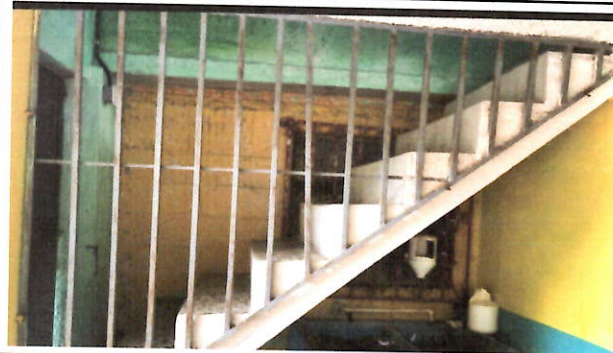
Foto 8: MANTENIMIENTO DE BARANDAS Reparación o sustitución de barandales metálicos, incluyendo fijaciones, pintura y soldaduras.
