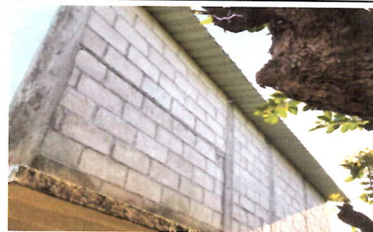
Foto 6: REPARACIÓN DE REPELLO Y CERNIDO DE PAREDES Reparación de repello y cernido en muro de mampostería con aplicación de acabado uniforme, cocina y dirección
