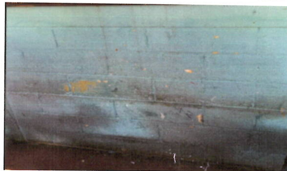
Foto 2: PINTURA EN MUROS INTERIOR Y EXTERIOR Preparación de la superficie y aplicación de pintura a dos manos, en paredes interiores y exteriores del establecimiento. En aulas
