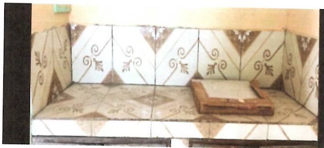
Foto 7: REPARACIÓN O SUSTITUCIÓN DE AZULEJO Sustitución de piso Tipo: azulejo, trabajo de nivelación, instalación alineada y sizado en juntas. En cocina y baños
