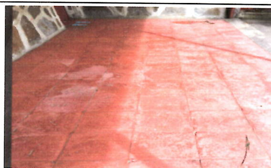
Foto 4: PISO Sustitución de piso de concreto con acabado liso por piso cerámicos antideslizante, incluyendo preparación de superficie y nivelación. En aulas y corredor
