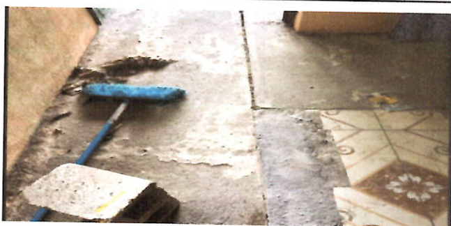
Foto 9: PISO Sustitución de piso cerámico por piso cerámicos antidelizante, incluyendo preparación de superficie y nivelación. En cocina, baños y lavamanos
