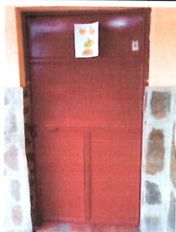
Foto 3: PUERTAS Suministro e instalación de puerta metálica, incluyendo chapa, bisagras.
