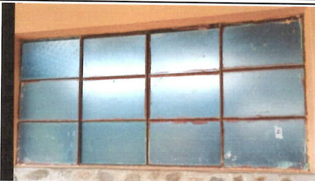
Foto 1: VENTANAS Sustitución de ventanas; sistema de apertura: Corredizas, Perfiles color blanco estandar, Material del marco: PVC Material de la ventana: Vidrio, sellado perimetral.
